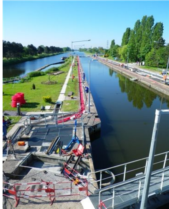
Vue des travaux sur l'écluse de Talange
