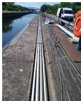
Les nouvelles conduites dans le caniveau
