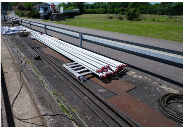
Les deux générations de conduites
